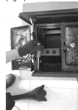
**7** - *Encaixe os pés da parte frontal do fogão nos parafusos (Fig. 5), e realize o aperto recolocando a porca com auxílio de chave de fenda e chave de boca. (Fig. 6)*
